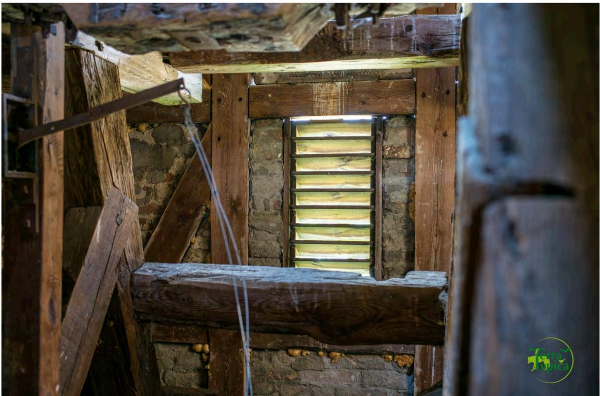
Abbildung 44: Glockenetape des Turmes mit Schallöffnung
