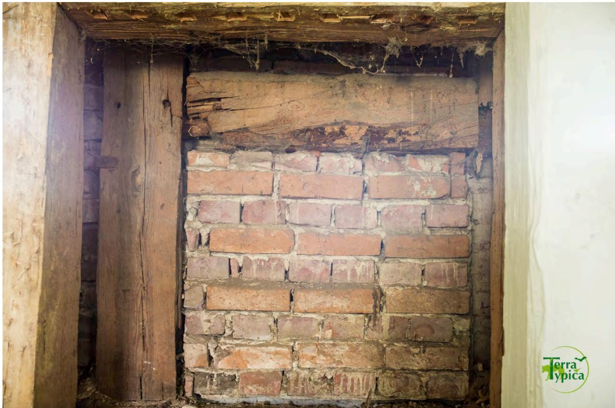
Abbildung 35: Hohlräume zwischen Innen- und Außenmauer des Schiffes
