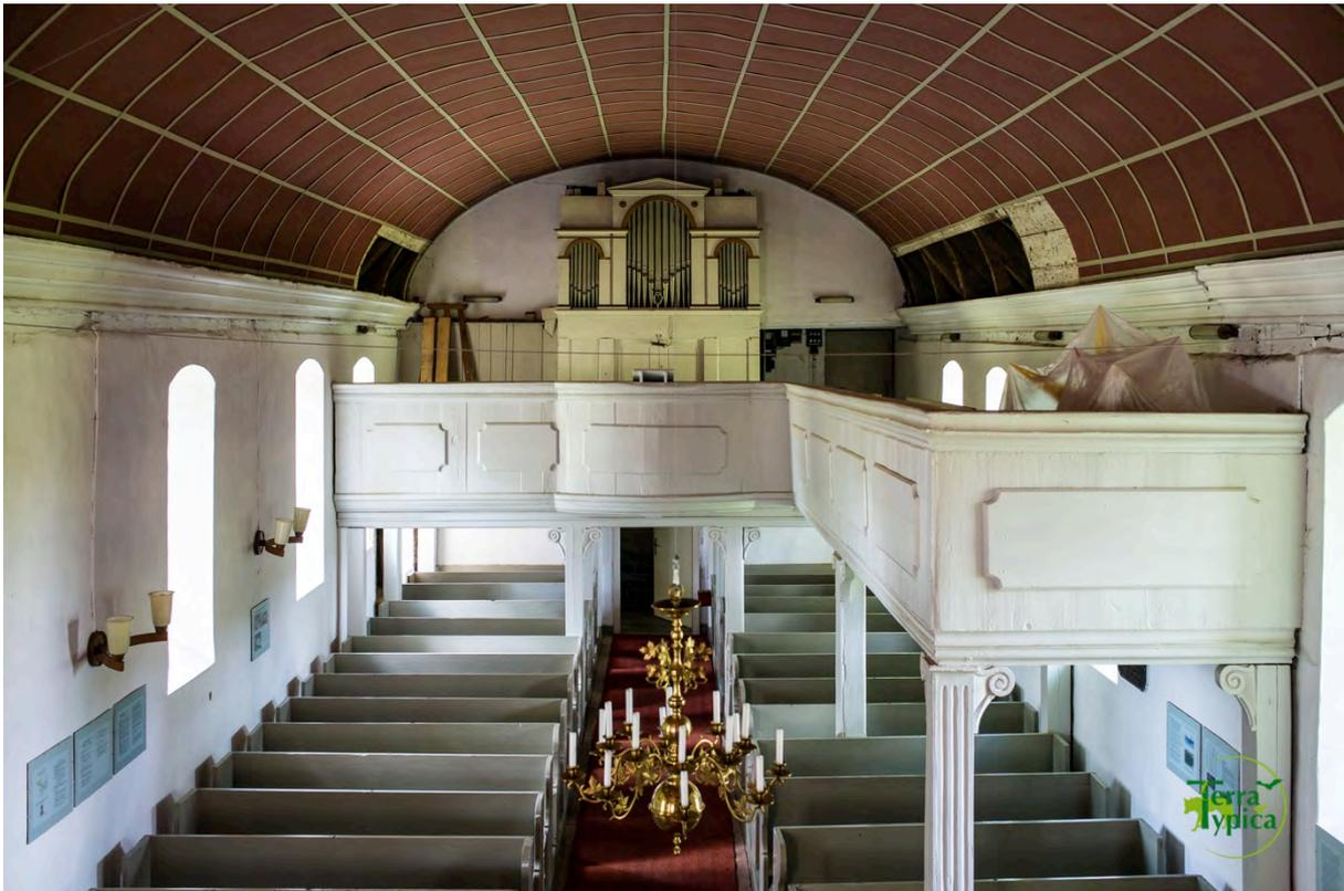
Abbildung 33: Kirchenschiff innen (hinten rechts und links an Gewölbeseiten das geöffnete Hohlraumssystem zwischen Dachseiten und Innenraum des Schiffes)
