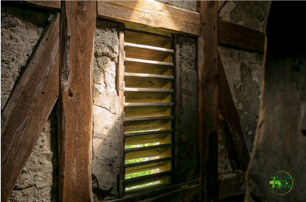
Abbildung 45: Glockenetape des Turmes mit Schallöffnung
